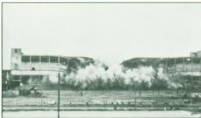
De sloop van de 'oude' Jefferson-fabriek (rond 1907)
