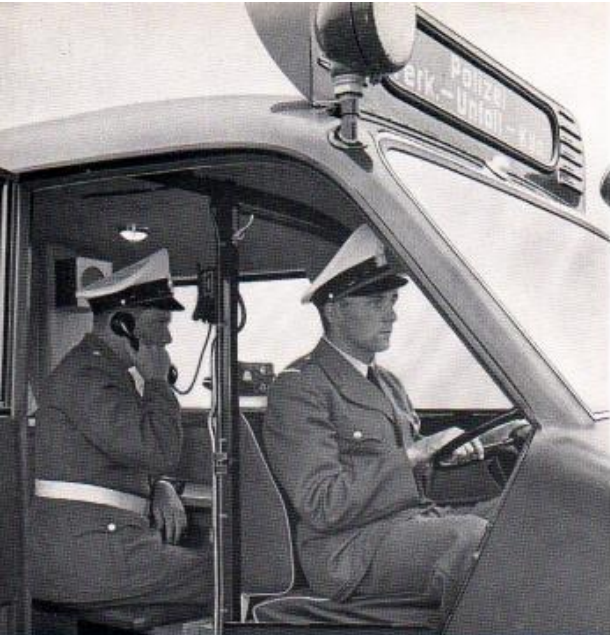
Im Fahrerhaus des DKW-Verkehrsunfall-Kommandowagens haben Fahrer und Beifahrer durch die große Windschutzscheibe beste Sicht bis dicht an den Wagen heran. Unter der durchgehenden Sitzbank ist die Sprechfunk-Anlage untergebracht.
